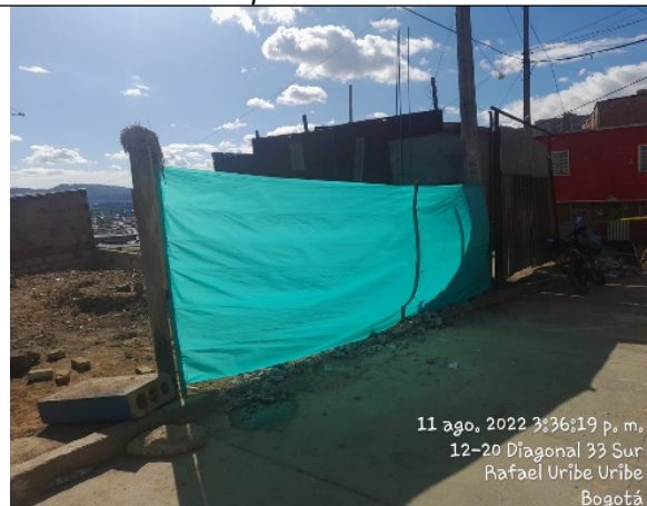
Fotografía No. 11 Cerramiento del predio con polisombra.
